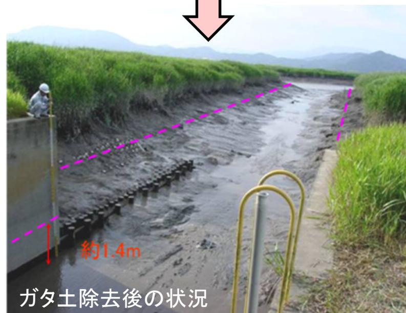
対応策の一例として浚渫船によるガタ土除去。
