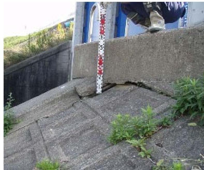
軟弱層の圧密沈下に伴う不同沈下により、護岸ブロックの変状が生じた。
